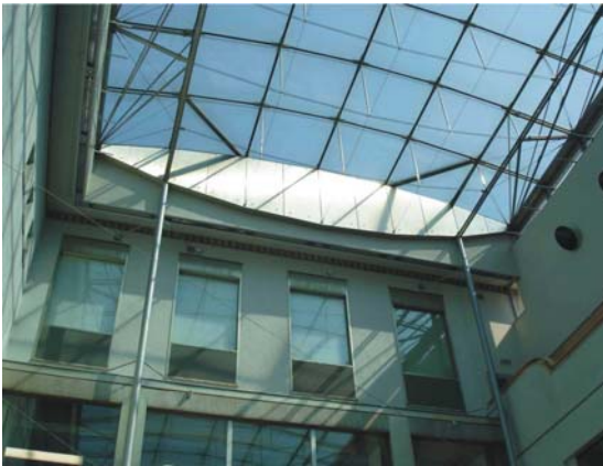
Figure 4 Atrium space of Wienmuseum Karlsplatz
