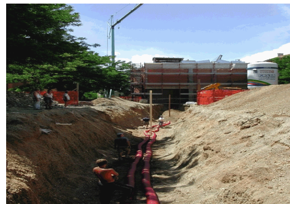
Figure 3: Pose d'un tuyau dans le sol [Ref. 1]
