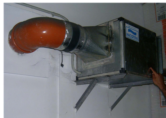
Figure 9: Point où l'air provenant du tube enterré est introduit dans le bâtiment
