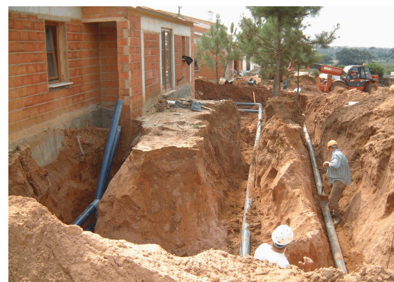
Figure 4: Pose d'un tuyau dans le sol
