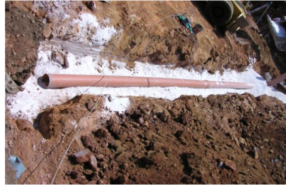
Figure 5: Pose d'un tuyau dans le sol en utilisant du sable pour améliorer le contact thermique entre le tuyau et le sol
