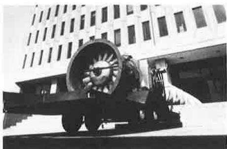
Abb. 3: Ansicht des Gebläses und der Luftstrom-Messstrecke für die Differenzdruck-Messmethode, wie sie von Tamura und Shaw (NRC, Ottawa) für grosse Gebäude eingesetzt wird.
