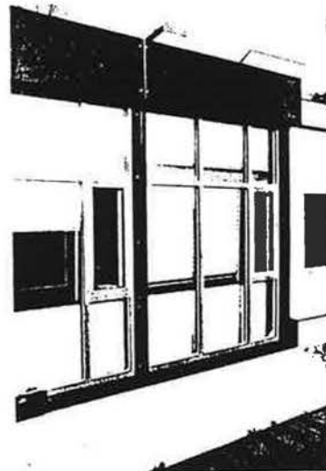
Bild 6. Die Chamäleonfassade dunkel, auf Absorption eingestellt
