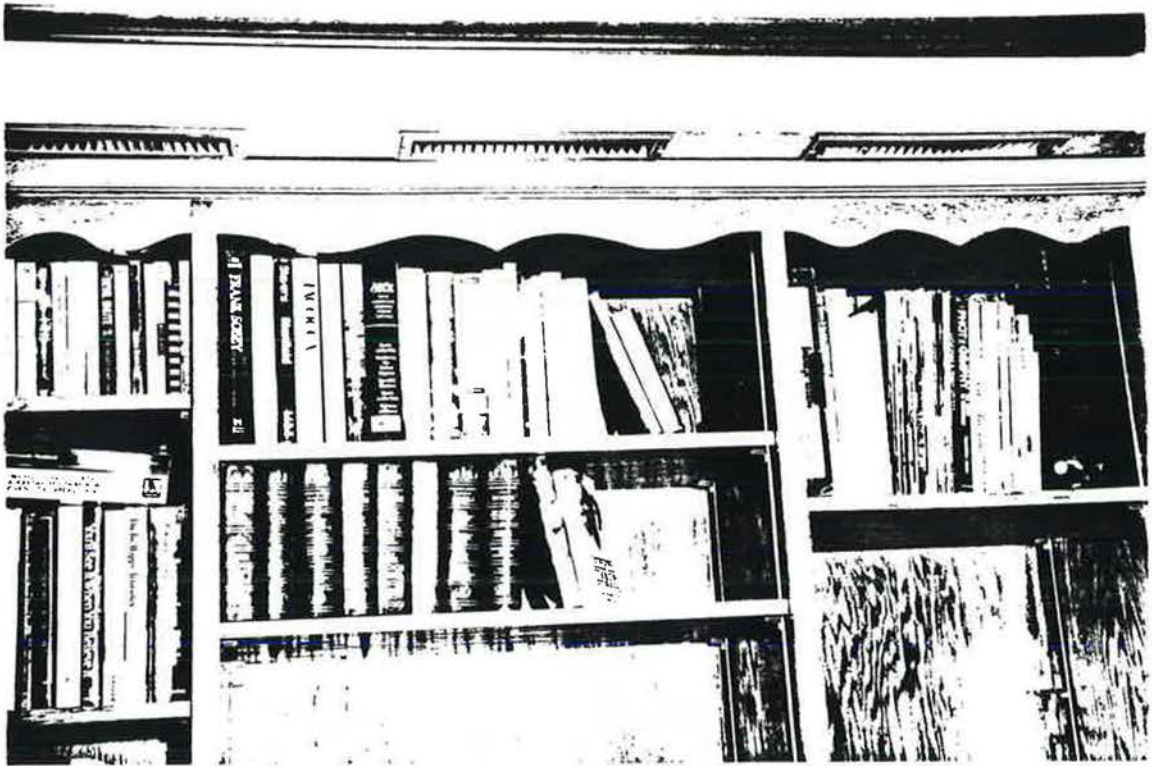
Grilles d'aspiration au-dessus de la bibliothèque
