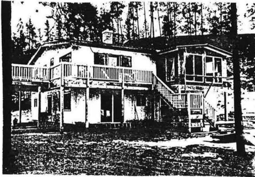
Vue extérieure montrant la pièce ajoutée en construction
