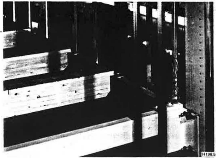
Bild 5: Klemmbefestigung der Deckenbalken
