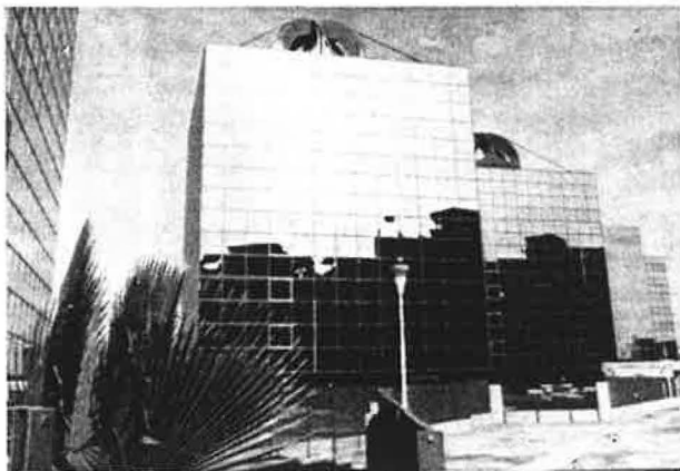
figura 1 - Panoramica degli edifici a facciata continua alluminio-vetro su cui sono state effettuate le misure di radiazione
