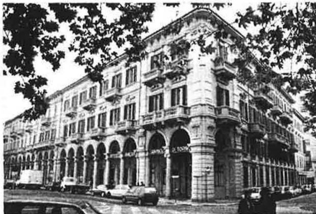
FIGURA 1 Vista generale dell'edificio
