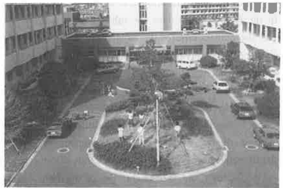
(b) actual condition
