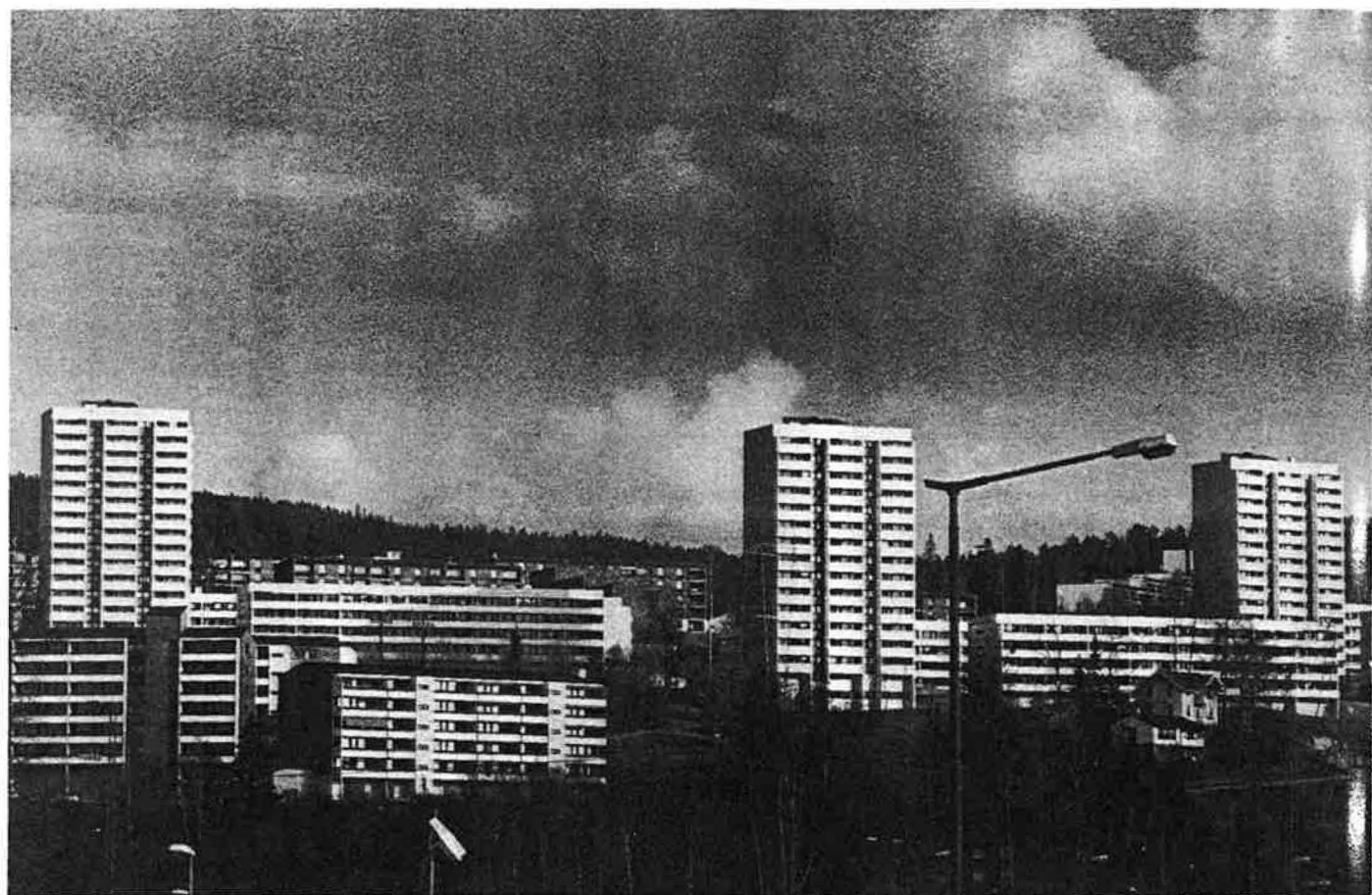
Hus ska byggas tätare annars går det inte att ventilera och värma dem på ett sunt sätt, menade byggnadsfysikerna.
