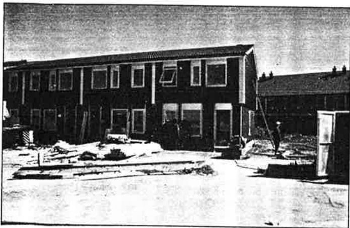
Houtskeletbouwwoning te Alkmaar
