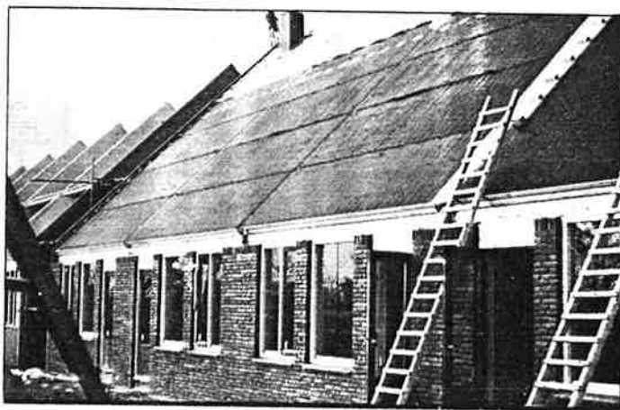
Zonne-energiewoning met warmtebuffer te Alkmaar
