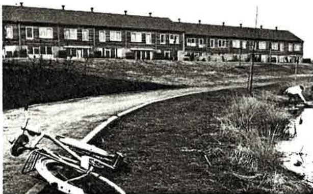
Foto 1: De Rietlanden in Emmen. Een ruim opgezet nieuwbouwplan met als grootste bijzonderheid het grote percentage woningen dat uitgevoerd is met luchtverwarming, gebalanceerde ventilatie en een warmte-terugwin-systeem.
