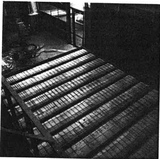
Foto 2: De vloer is een polystyreen broodjesvloer met een k -waarde van ca. 0,5 \text{ W/m}^2\text{K} .
