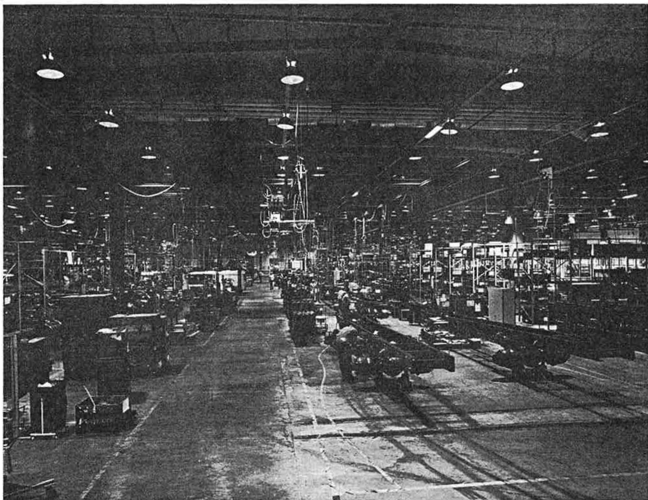
Verkstadslokal med omblandande ventilation.
