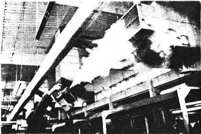
Bild 6. SL-Baustein wirkt als Abluftschacht
