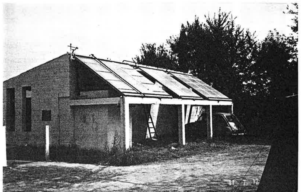
Capteurs solaires : implantation dans un champ aérodynamique particulier
