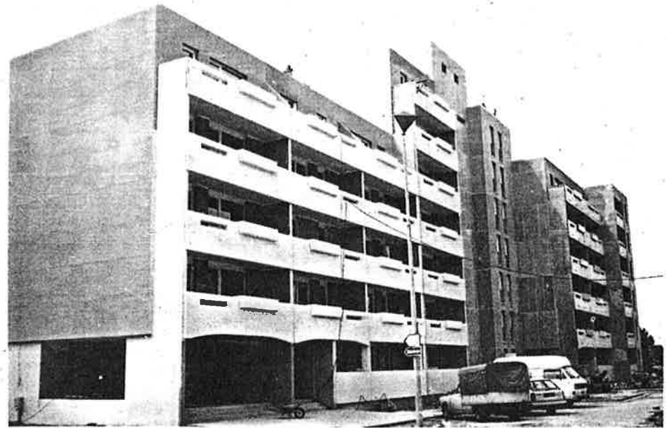
Figure 17 L'ensemble X (façades isolées par l'intérieur, pignons isolés par l'extérieur)
