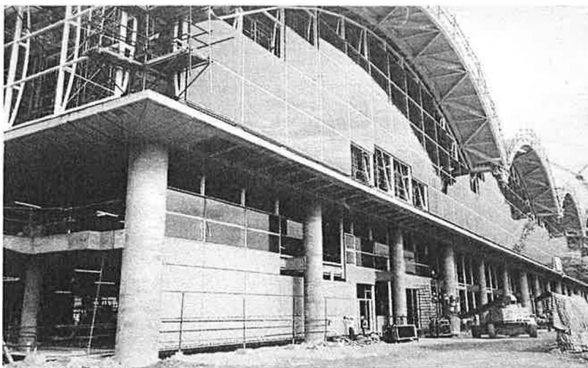
Zorg dat het gebouw zo vroeg mogelijk glas- en waterdicht is om hemelwater zoveel mogelijk te weren
