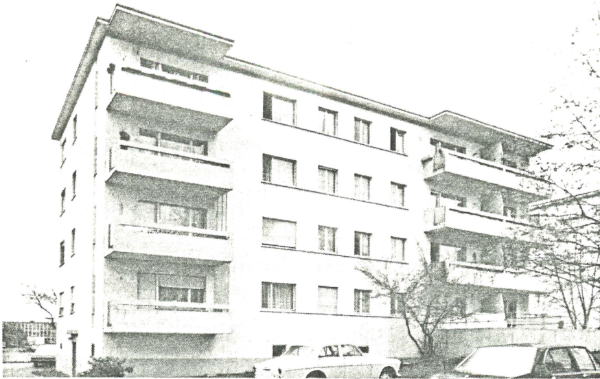
Fig. 7: Ansicht-Aufnahme des einen der beiden Mess- gebäude, für die Lüftungsverhalten- Un- tersuchung resp. dessen Ost- und schmaler Süd- fassade
