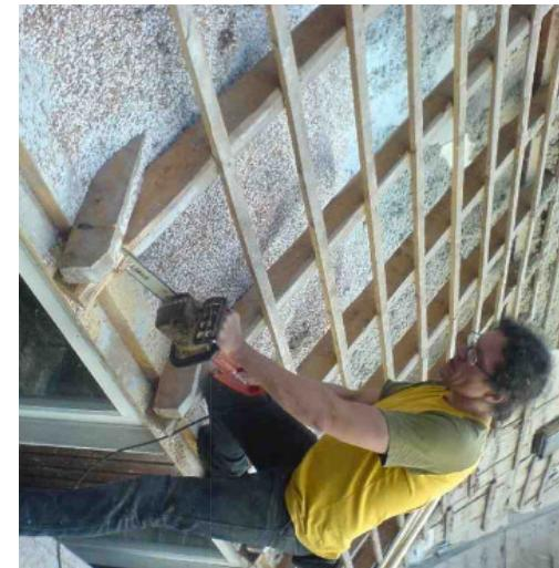
Anschluss der Luftdichtungsbahn
