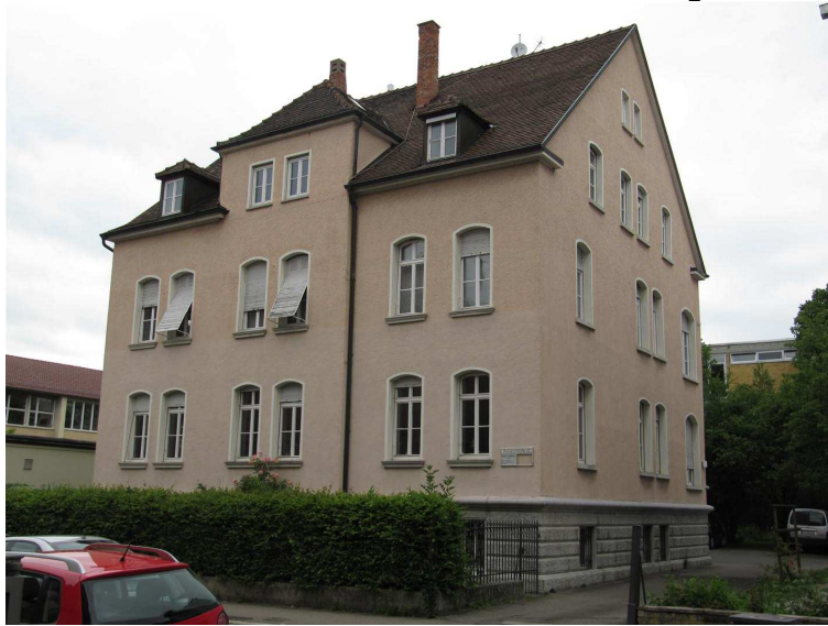
Bild 1: Gebäude vor Modernisierung
