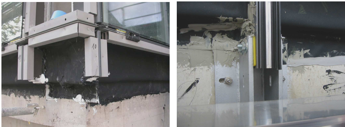
Bild 4 und 5: Äußere Abdichtung an die Pfosten und Riegel
