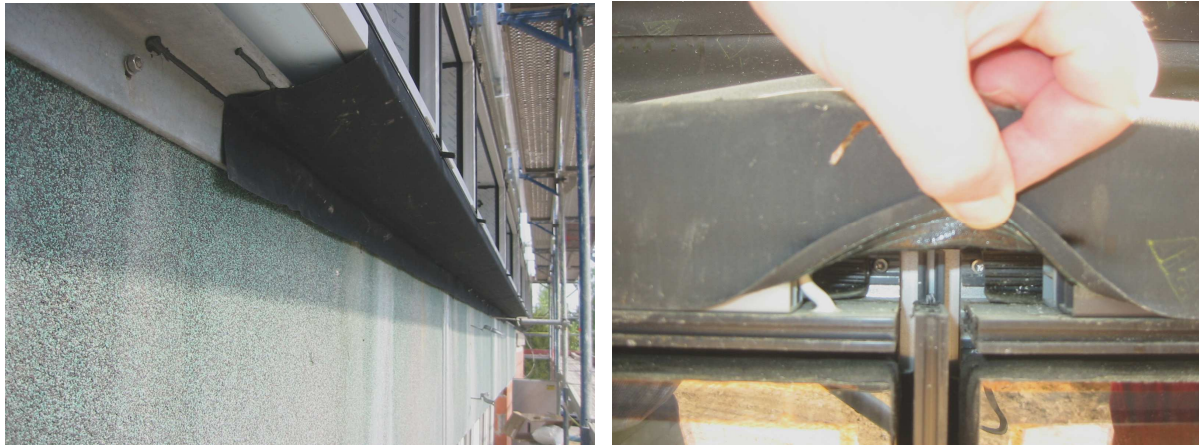
Bild 2 und 3: Äußere Abdichtung an das Glas- Distanzprofil
