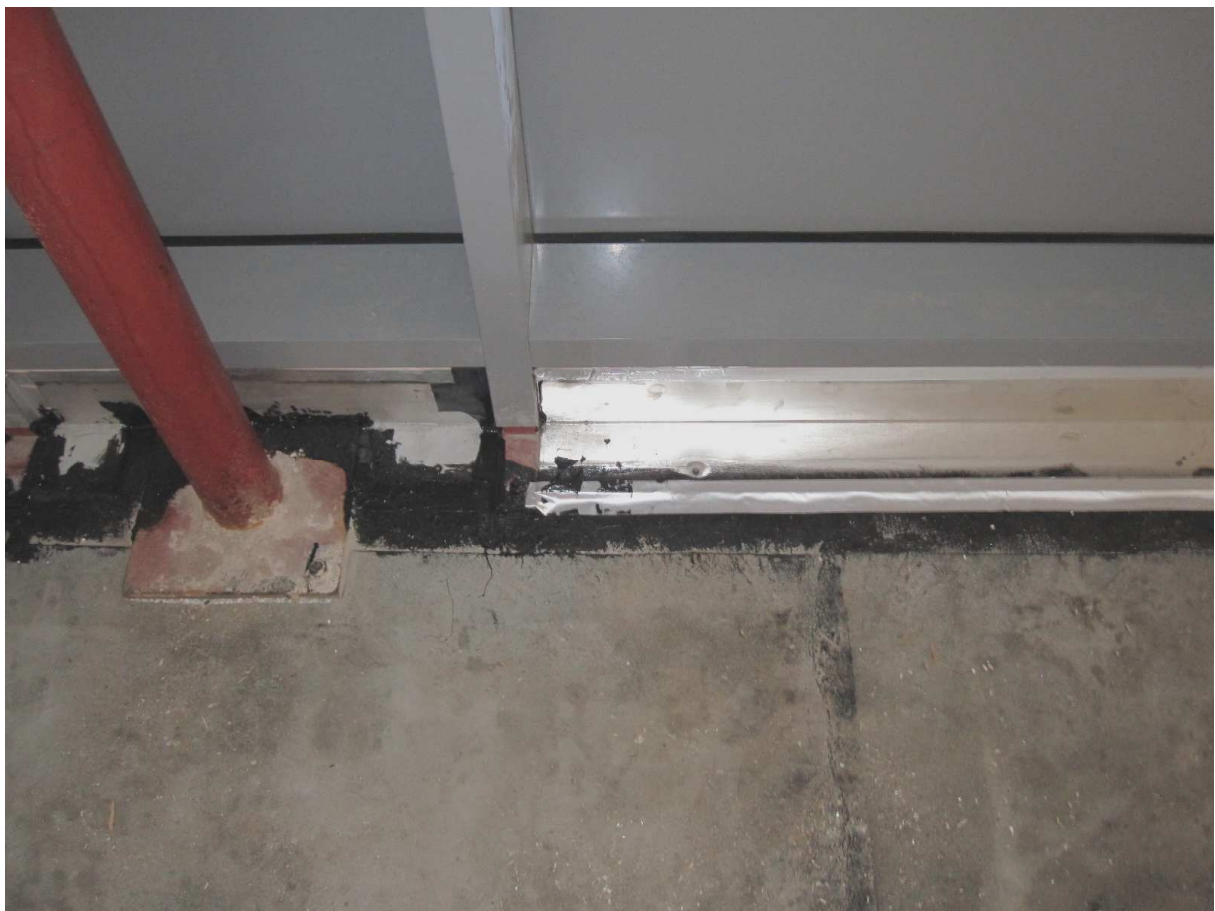
Bild 1: Raumseitige untere Bauteilanschlüsse von Pfosten- Riegel- Konstruktionen
