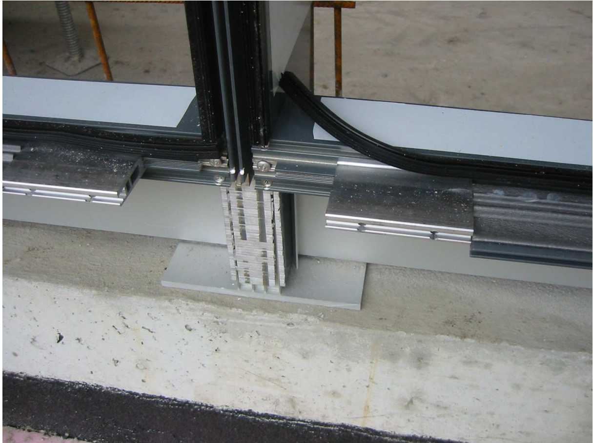
Bild 9: Ausfräsung der Pfosten im Anschlussbereich
