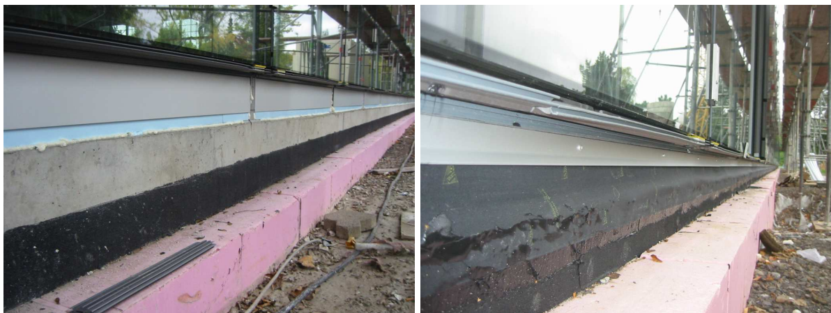
Bild 10 und 11: Herstellung des luftdichtenden Anschlusses
