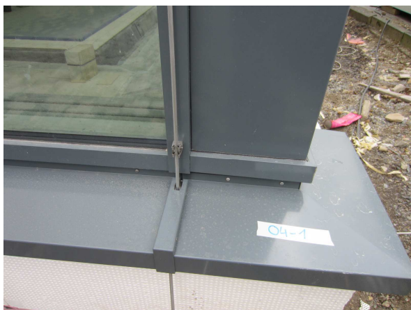
Bild 18: Leitungsanordnung in Abdeckprofilen Bild 19: Blitzschutzleitungen
