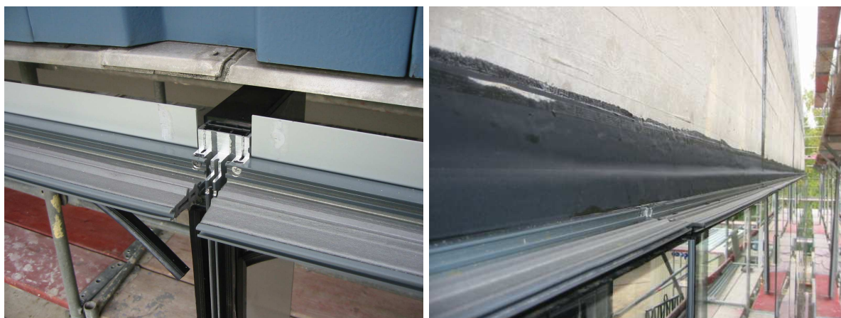
Bild 13 und 14: Ausführung der oberen Bauteilanschlüsse
