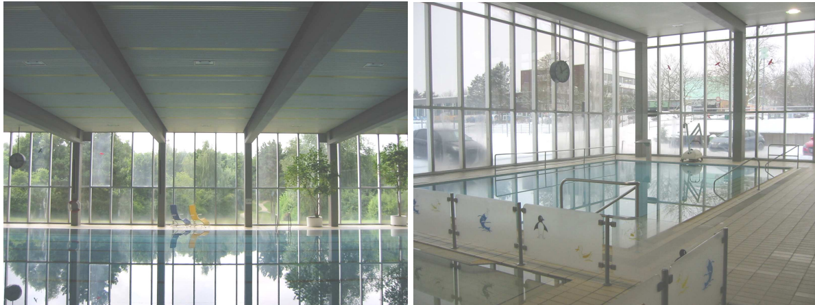
Bild 6 und 7: Innenansichten der Pfosten- Riegel- Fassade
