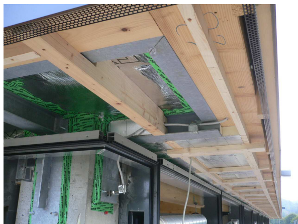
Bild 18: Leitungsanordnung in Abdeckprofilen Bild 19: Blitzschutzleitungen
