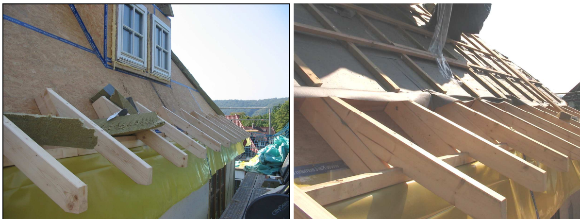
Abb. 9 und 10: Auf- Sparren- Dämmsystem mit Schubsicherung und Aufschieblingen zur Ausbildung der Dachüberstände.
