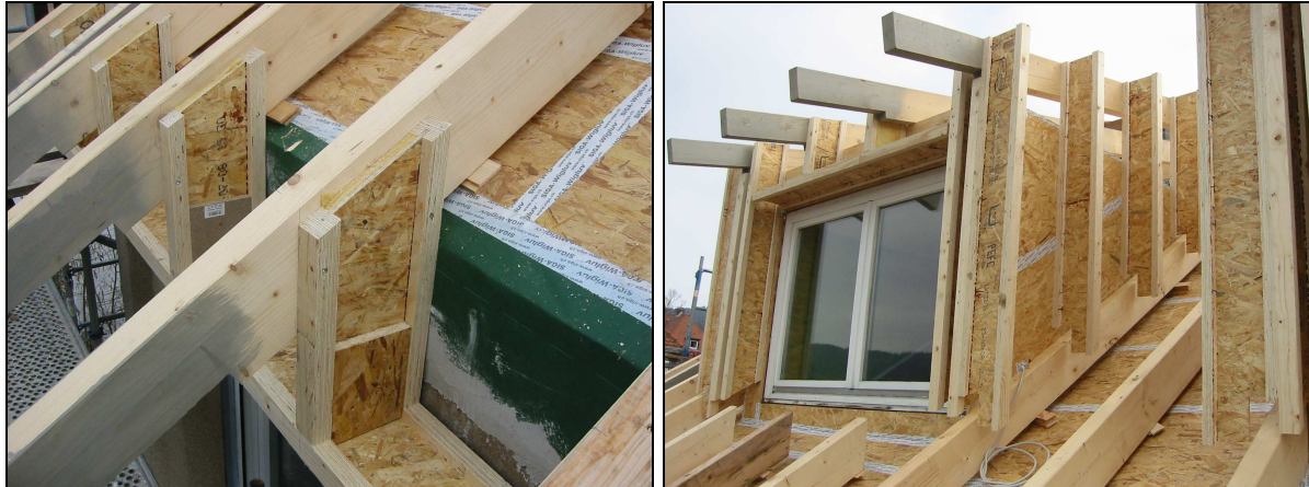
Abb. 7 und 8: Trägersysteme im Wandbereich, Sparren aus KVH mit wärmedämmendem Unterdach
