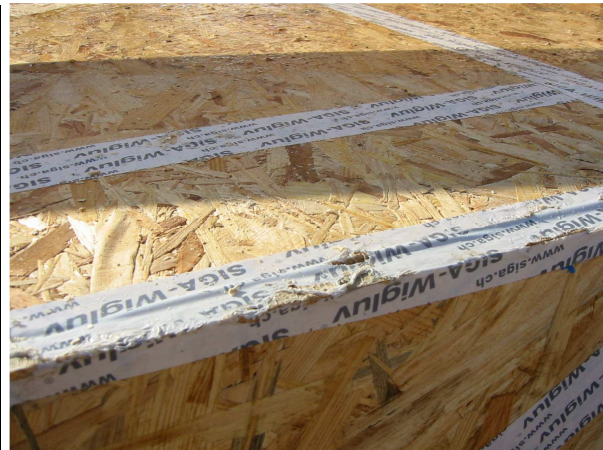
Abb. 13: Beschädigungen der Verklebungen
