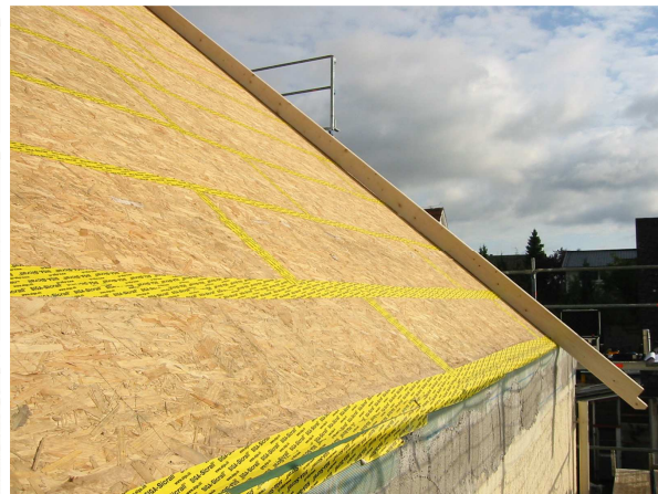
Abb.4: OSB- Beplankung als Luftdichtung
