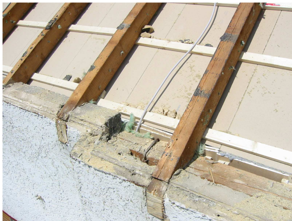
Abb.2: Abtrennen der Überstände
