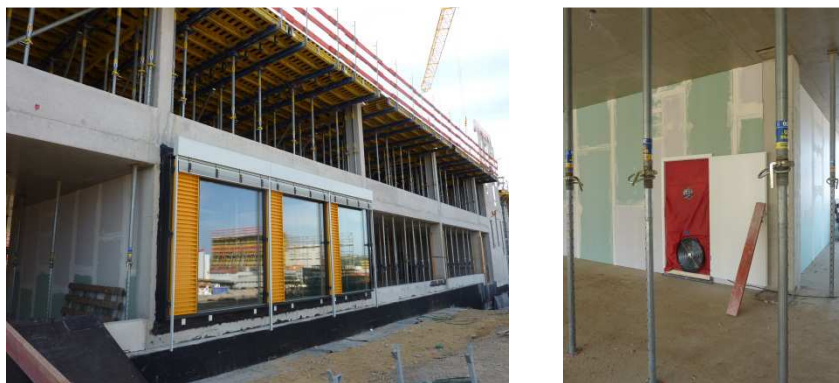
Abb. 5: Musterfassade mit angeschlossener Einhausung, so dass die Luftdichtheit des Fassadelementes und der Anschlussfuge vorab geprüft werden konnten. In diesem Fall waren Nachbesserungen und ein zweiter Luftdichtheitstest nötig.
