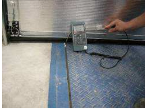
Abb. 7: Ausschnitt, bewegliche Ladebrücke mit eingebauter Dichtung. Lediglich in der Torebene verbleibt eine deutlich sichtbare Luftleckage (Quelle: Bauphysikkalender 2012)
