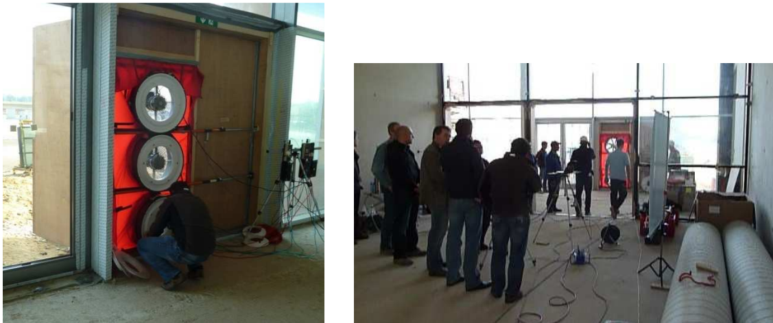
Abb. 9: Während der BlowerDoor Messung im Gebäude Public
