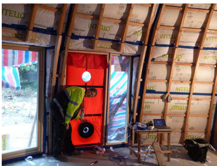
Bild 2: Aus Gewichtsgrunden kam hier ein DuctBlaster zum Einsatz
