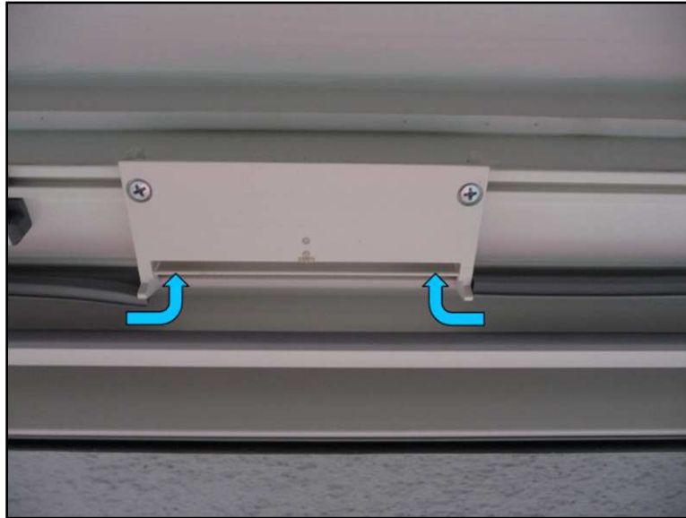
Bild 2: Ansicht Fensterfalzlüfter mit Einströmöffnung
