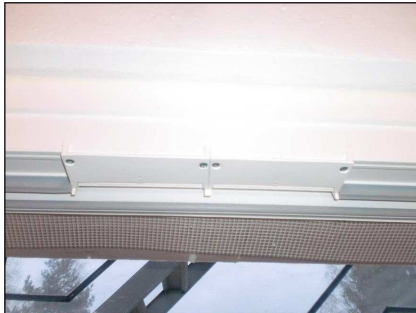
Bild 4: Ansicht Fensterfalzlüfter mit Einströmöffnung
