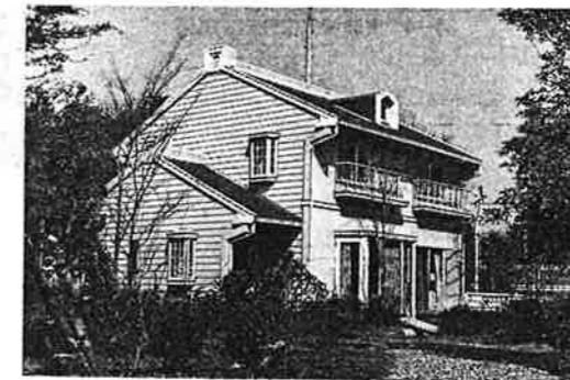
写真-1 実験棟外観
