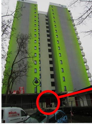
One BlowerDoor system
