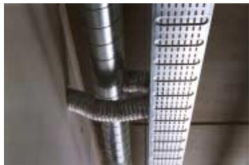
*Figure 115 : Flexible duct*
