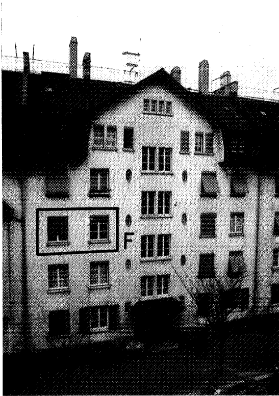
Bild A 8 (EMPA-Nr. 74127/32) Strassenfassade des Messgebäudes (F)
