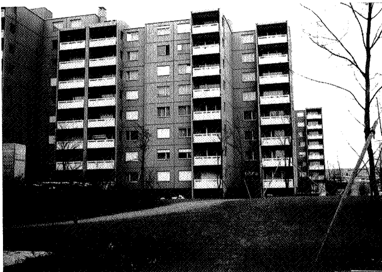
Bild A 1 (Foto EMPA-Nr. 72574/11) Ansicht der SW-Fassade des Gebäudes, in dem sich die Wohnungen A, B und C befinden.
