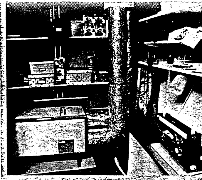
Här har ventilationsaggregatet installerats i ett förrådsrum i suter-rängvåningen.
