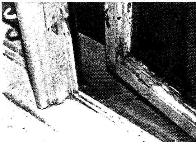
Figur 33 Kondens har medført dårlig trevirke ved kittfals. Hengsler og beslag sitter godt. Bør utbedres
