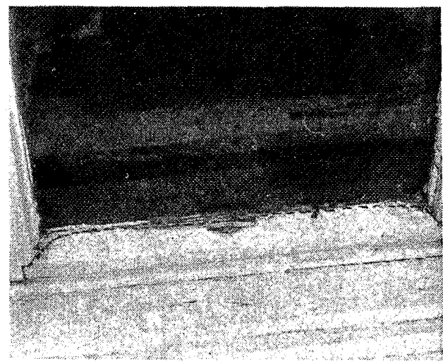
Figur 35 Dårlig vedlikehold har ført til lekkasje og råte. Tvilsomt om utbedring vil lønne seg.
