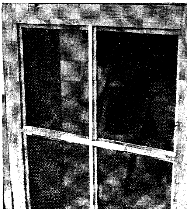
Figur 58 Nytt trevirke erstatter det gamle.
