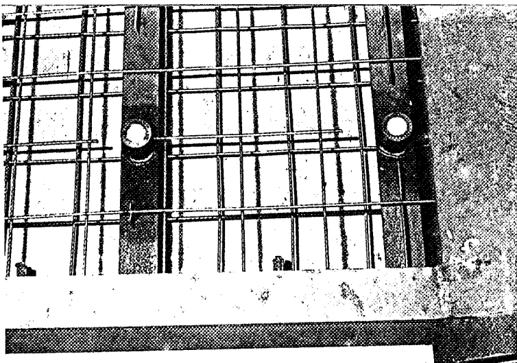
Afb. 38 - Verankeringschulzen van de proefmuur (eveneens gevuld met polystyreen)
