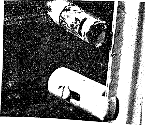
Fig. VIII - Exemple d'importantes fuites d'air par les tuyaux de fixation des radiateurs. Ceux-ci se prolongent jusqu'au vide ventilé. Une fissure suffit déjà pour produire des fuites.
