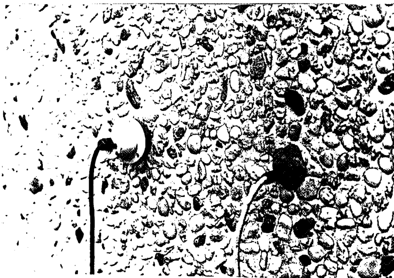
Afb. 63 - Links : vochttopnemer Rechts : temperaturopnemer : het gevoelige deel zit 4 cm in de muur.
