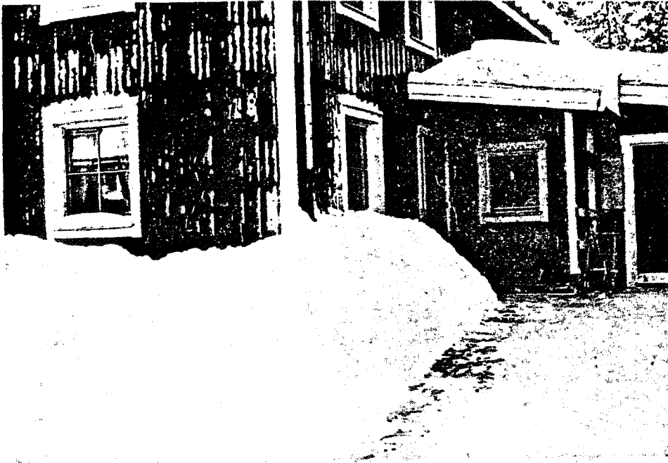
FIG D:9a Uppskottad snö mot det hörn i köket där låga temperaturer uppmättes
