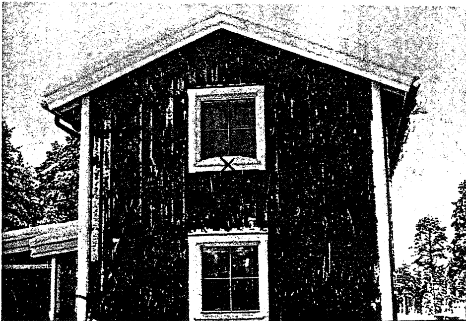
FIG D:9b 0) Hörn i köket där låg temperatur uppmättes x) Sovrumsfönstren där viss kondens utbildats. Gaveln vetter mot öster
