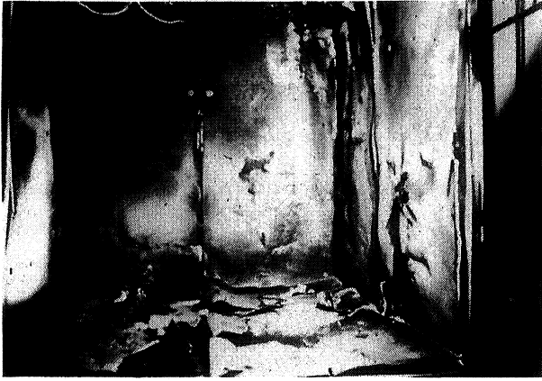
(d) Extent of damage
