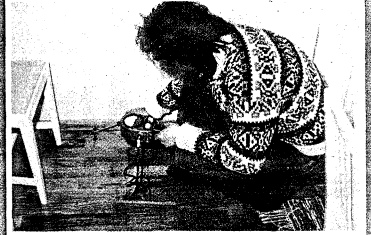
Lufthastigheten vid förmodat luftläckage kontrolleras med en varmtrådsanemometer.
