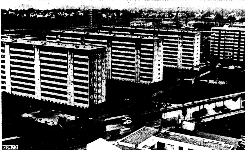
Bild 19: Wohngebäude in der näheren Umgebung des Wohnhochhauses Ramses nach einer kurzen und intensiven Schlagregeneinwirkung
