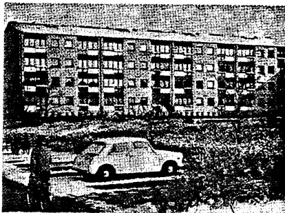
Fig. 17. Bolig nr. 19. Her er foretaget: Oplukkelige vinduer og altandøre er forsynet med tætningslister i falsene. Entrédør er forsynet med tætningslister i karmlysnings. Brevindkast er justeret. Ved altanpartiet, der er udført som en let trækonstruktion, er afdækningslister demonteret, og de bagved liggende fuger er udfyldt med fugemasse. Indvendige brystningsbeklædningsplader, der var fastholdt med glaslister, blev ligeledes demonteret, og pladen blev derefter klem fast i fugemasse.
