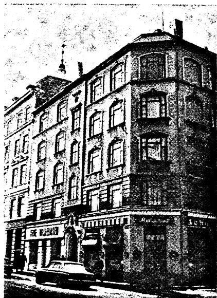
Fig. 20. Bolig nr. 49. Målingerne blev foretaget i en 3-værelses lejlighed i øverste etage. Vinduerne mod gaden er de to, som ses øverst til venstre i den forreste bygning.
