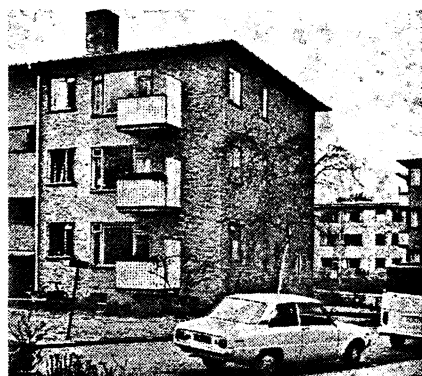
Fig. 19. Bolig nr. 42. Her er foretaget: Tætning i fals ved vinduer i køkken og værelse. Tætning af forsatsrammer på vindue og dør i altanparti til stue. Altandør tillige afhøvet og justeret. Tætningslister påsat karmlysnings ved entrédør. Etablering af underlysramme i forbindelse med ovenlysskakt i badeværelse. Fugning udvendig omkring altandør og indvendig mellem vindueskarm og fliser i køkken.
